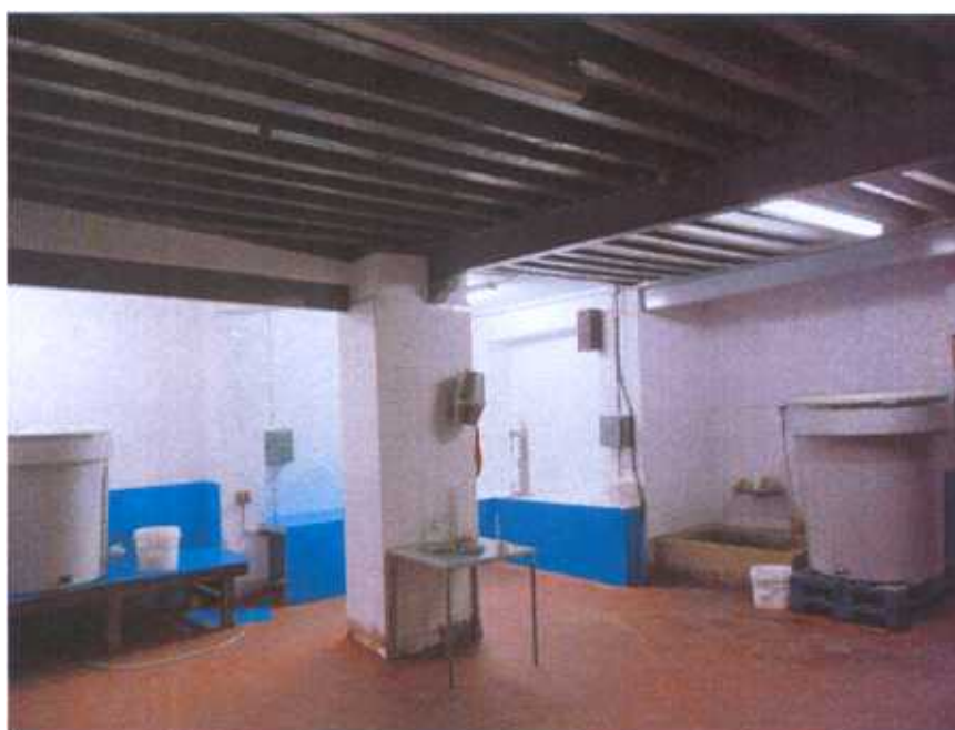
Fotografía n° 20: Esquina sureste del inmueble. Reconstruida en la década de 1.960. Crujía a C/ Montoya, planta baja
