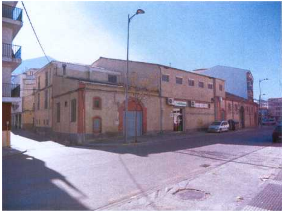
Fotografía nº 1: Vista del inmueble desde Avenida Pérez del Álamo mirando hacia el oeste, y embocadura de calle Aliatar
