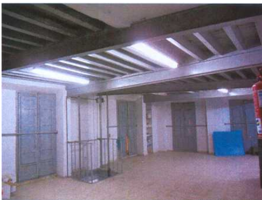
Fotografía nº 21: Esquina sureste del inmueble. Reconstruida en la década de 1.960. Crujía a C/ Montoya, planta primera
