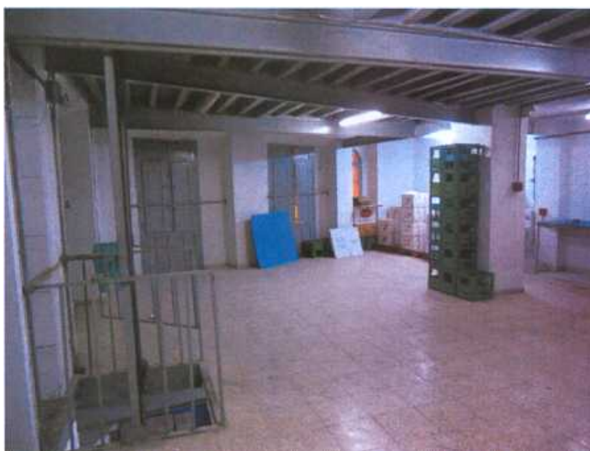
Fotografía nº 22: Esquina sureste del inmueble. Reconstruida en la década de 1.960. Crujía a C/ Montoya, planta primera
