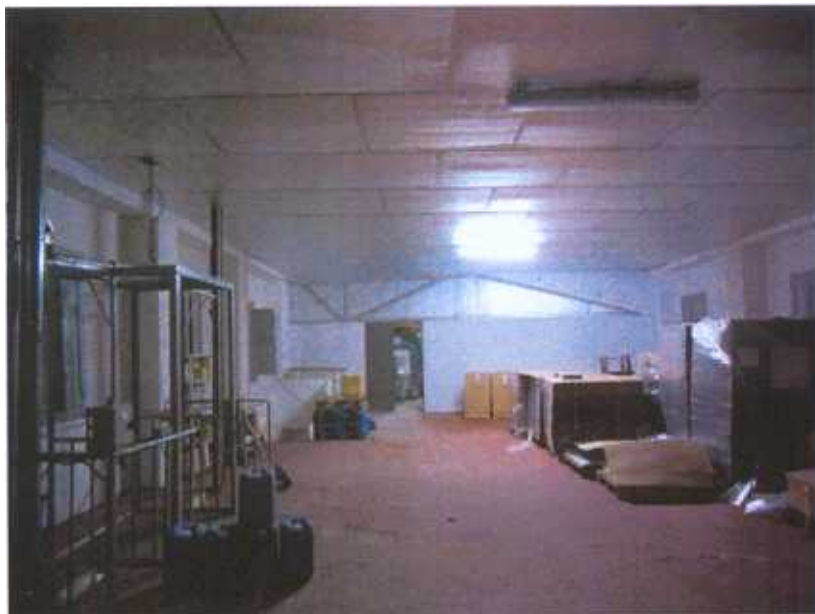
Fotografía nº 15: Vista de la nave occidental. Crujía de C/ Montoya, Planta segunda. Cerchas de cubierta.
