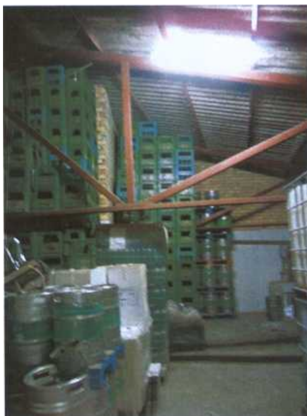
Fotografía nº 16: Vista de la nave occidental. Crujía de C/ Montoya, Planta segunda. Cerchas de cubierta.
