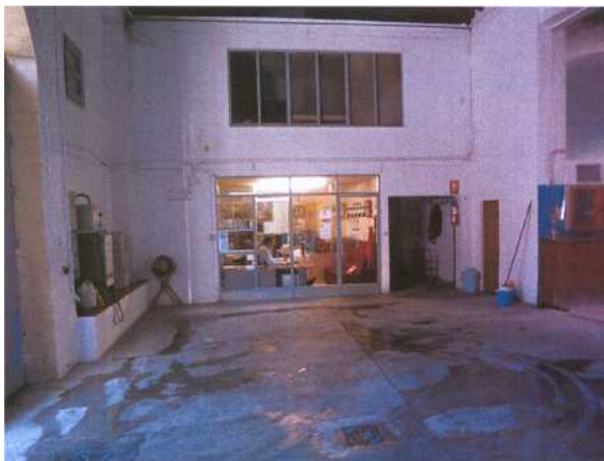
Fotografía nº 9: Vista hacia el este de la nave occidental del inmueble. Oficinas al fondo en planta baja y despacho en planta primera en 1ª Crujía a Avda. Pérez del Álamo
