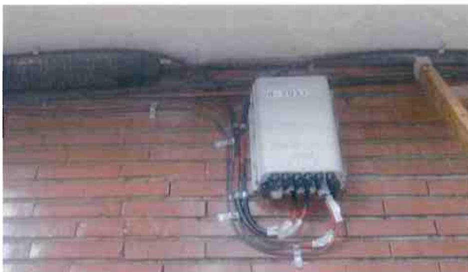
Ilustración 20. Detalle Caja terminal óptica (CTO) exterior.
