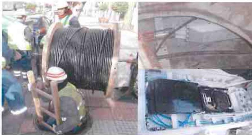
Ilustración 14. Tendido y empalme de cables en canalización.
