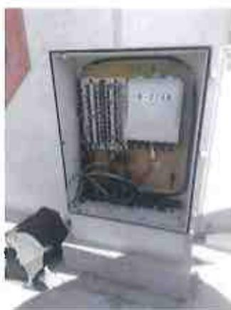
Ilustración 23. Caja terminal óptica (CTO) instalada en Pedestal.
