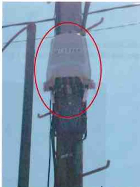
Ilustración 22. Caja terminal óptica (CTO) instalada en Poste.
